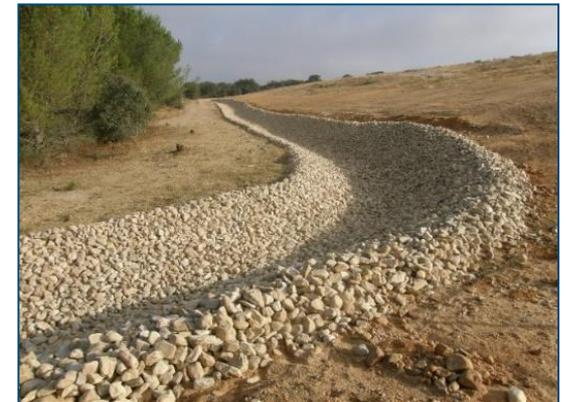
Actuaciones de estabilización in situ (protección de cauces y vaguadas, reparaciones de la multicapa de protección, etc.)
